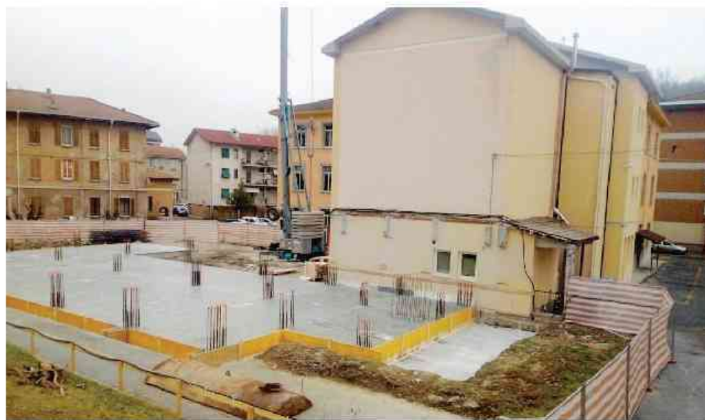
Il cantiere delle scuole Bertagna di Cengio Genepro
