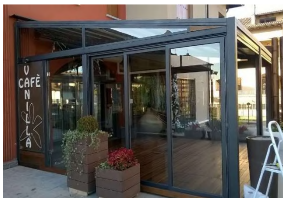
Esempio di dehor parzialmente aperto adiacente
